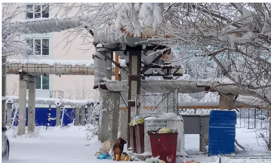
Рис. 2.1.1. Системы коммунальной инфраструктуры в г. Якутске, расположенные над землей
